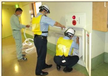
防災センター職員による 消火栓の確認
